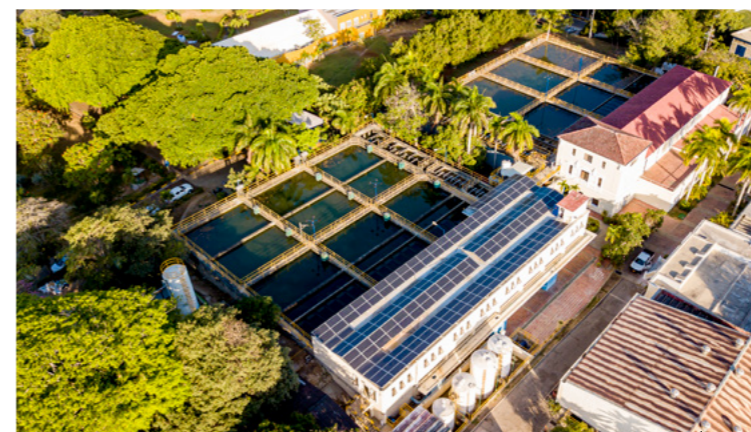
Planta de tratamiento de agua potable del Bosque. Aguas de Cartagena - ACUACAR Cartagena, Bolívar. Colombia
