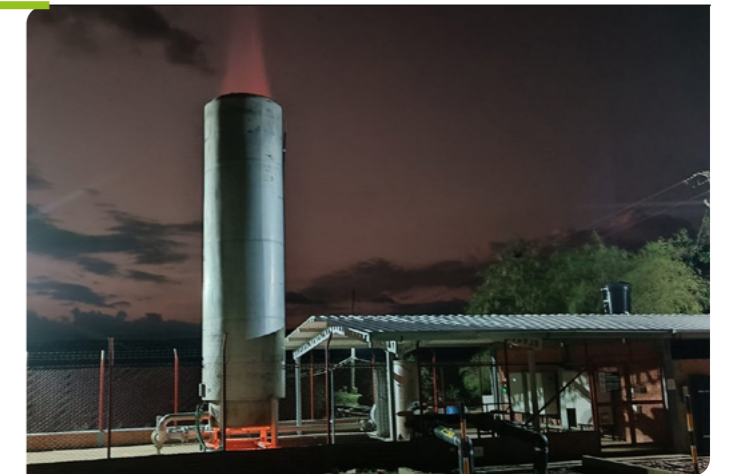
Proyecto transformación y aprovechamiento de metano - Parque Tecnológico Ambiental Guayabal Cúcuta, Norte de Santander. Colombia
